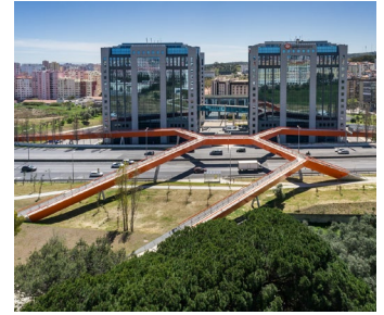
Ponte Segunda Circular Bridge, Lisbon
